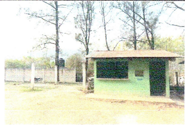
Foto 2: Cocina que se contempla mejorar con ampliación y cambio de techo
